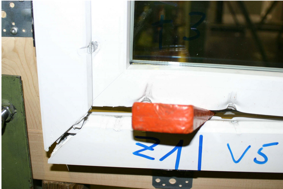
Bild 3 Schäden aus der manuellen Prüfung am Ecklager
